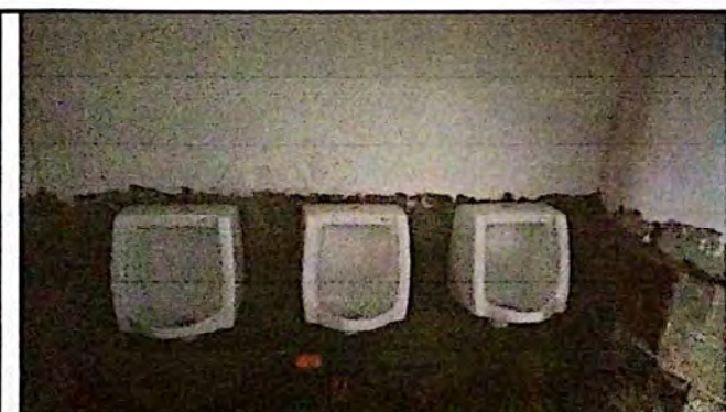
Foto 5: Sustitución de Mingitorio
