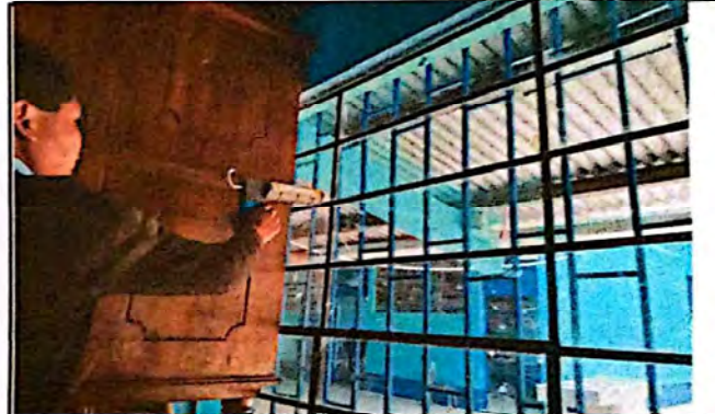
Foto 4: Sustrucción de Vidrios y de balcones
