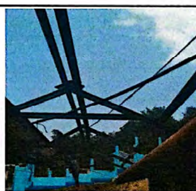
Foto 6: Sustitución de Lamina
