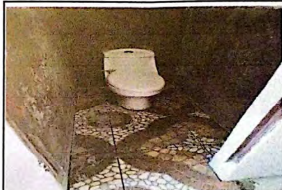
Foto 4: Sustitución de Inodoro
