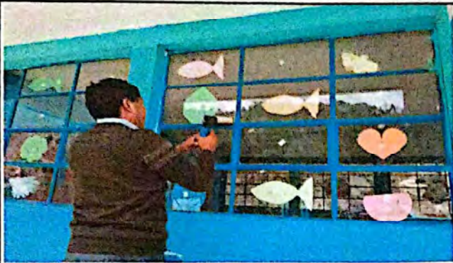
Foto1: Sustitución de vidrios
