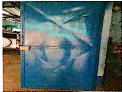
Foto 2: Sustitución de Chapa
