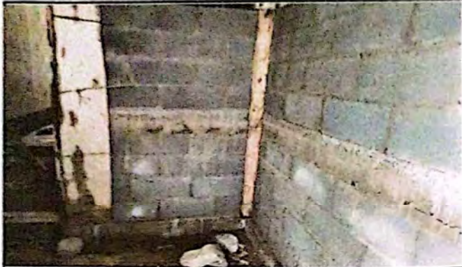
Foto 1: Sustrucción de Pared
