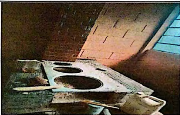
Foto 3: Sustitución de Estufa Rural
