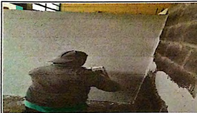
Foto 3: Sustrucción de Pared
